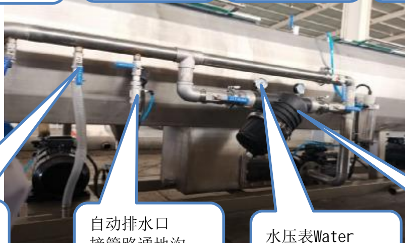
补(进)水口 接水源Make up (inlet)
